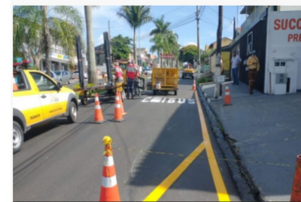
Após recape, Prefeitura conclui sinalização da Avenida Anhanguera
