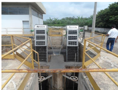
FIGURA 60: TRATAMENTO PRELIMINAR - SISTEMA DE GRADEAMENTO MECANIZADO (ELEVATÓRIA DE ESGOTO BRUTO).
