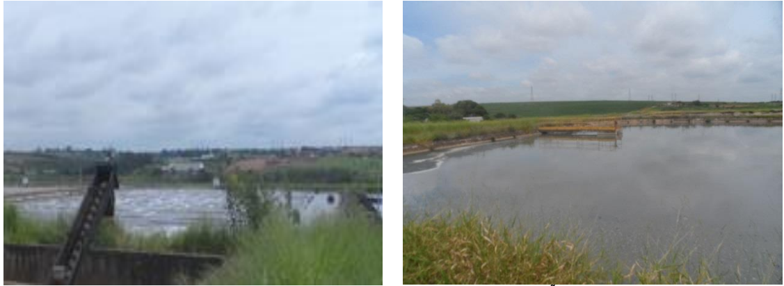
FIGURA 62: LAGOA AERADA COM AR DIFUSO E LAGOA DE SEDIMENTAÇÃO.
