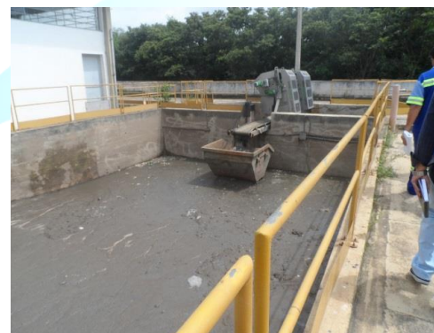
FIGURA 60: TRATAMENTO PRELIMINAR - SISTEMA DE GRADEAMENTO MECANIZADO (ELEVATÓRIA DE ESGOTO BRUTO).
