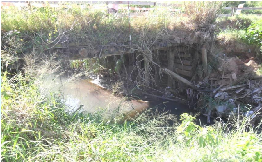
FIGURA 76: TRAVESSIA COM PAREDES LATERAIS DE MADEIRA E FUNDO DE TERRA, PÉSSIMO ESTADO DE CONSERVAÇÃO – PDDUSH RUA DAMIÃO ANTÔNIO DA SILVA À AVENIDA EMANCIPAÇÃO.
