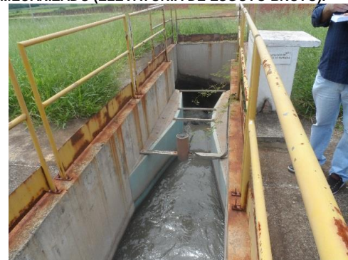
FIGURA 61: TRATAMENTO PRELIMINAR - SISTEMA DE GRADEAMENTO FINO MECANIZADO E CALHA PARSHALL COM MEDIDOR DE VAZÃO ONLINE.
