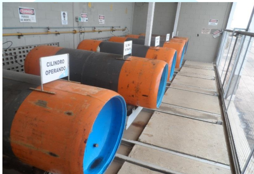
FIGURA 37: ARMAZENAMENTO DE CLORO GÁS UTILIZADO NA ETA-BOA ESPERANÇA.
