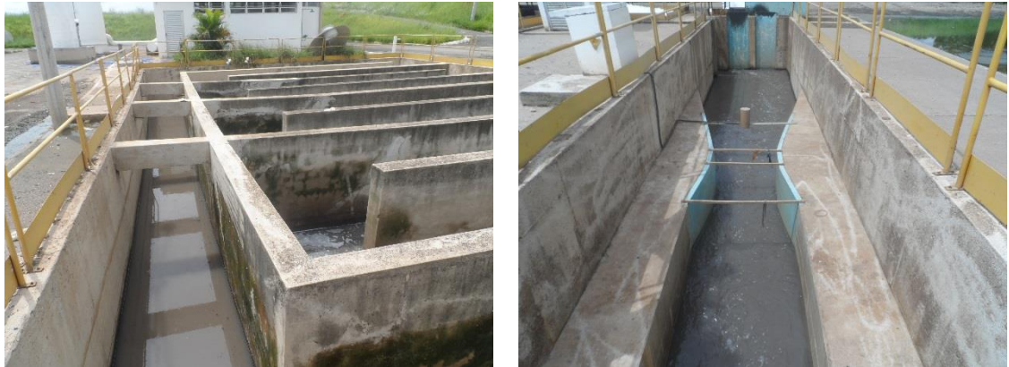
FIGURA 63: TANQUE DE CONTATO DE CLORO E CALHA PARSHALL DE ESGOTO TRATADO COM MEDIDOR DE VAZÃO ONLINE.
