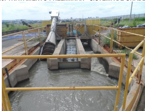
FIGURA 61: TRATAMENTO PRELIMINAR - SISTEMA DE GRADEAMENTO FINO MECANIZADO E CALHA PARSHALL COM MEDIDOR DE VAZÃO ONLINE.
