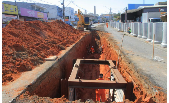
Trecho da avenida recebe tubos de drenagem de águas pluviais
